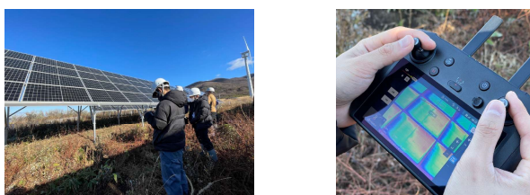
赤外線カメラを使用した太陽光パネルの点検
