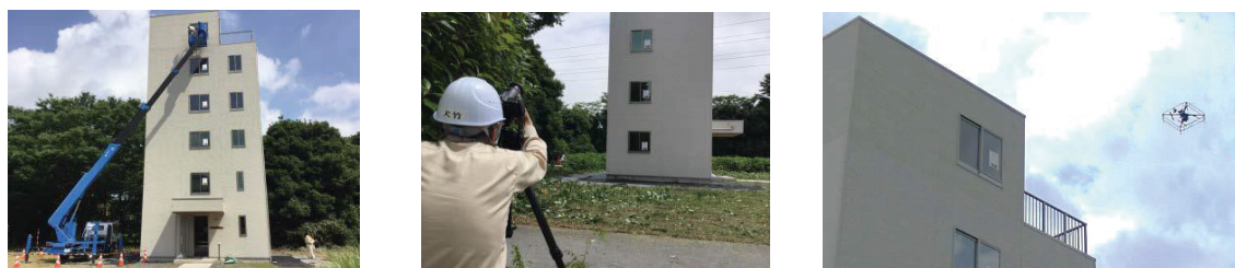
①高所作業（目視点検） ②地上撮影点検（カメラ撮影） ③ドローン撮影点検（カメラ撮影）
