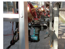
図5 子機のドリル作業
