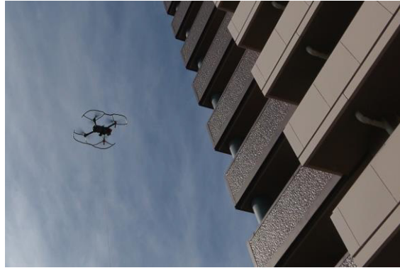
図5 ドローンによる外壁目視点検
