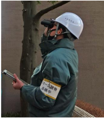
図4 地上からの外壁目視点検
