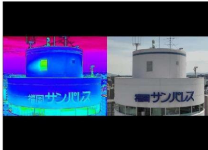
タワー棟 西面 1
