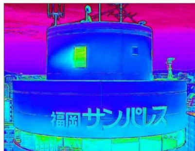
タワー棟 西面 2
