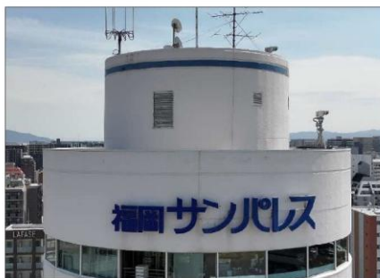
タワー棟 西面 3
